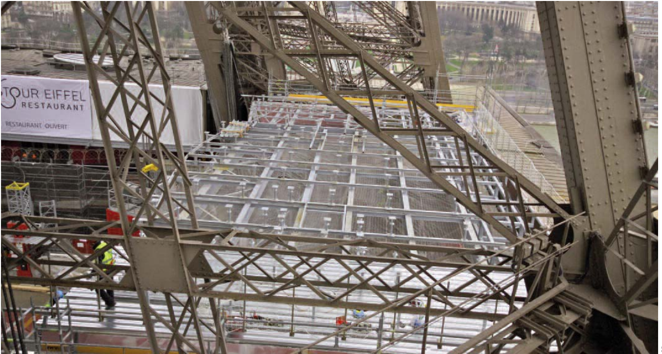
Montage de la surtoiture du pavillon Eiffel.
